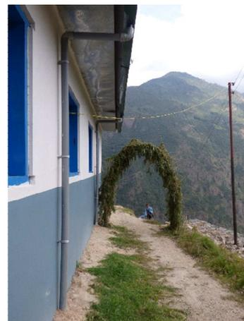
Figure 20 - système d'évacuation des eaux - Ecole de Tholodunga
