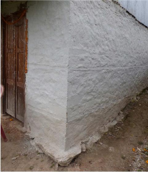
Figure 2737 - Trace de bande sismique - Rapcha - 31/10/2017
