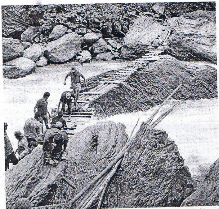
Cette passerelle en bambou est régulièrement emportée par les pluies de mousson.
