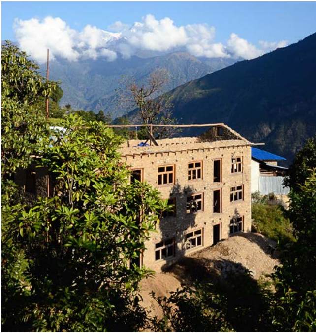
Lodge en construction
