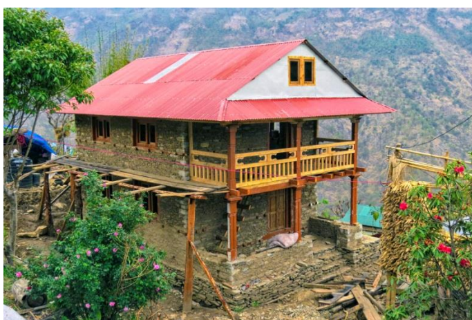
Première maison parasismique reconstruite (printemps 2017)
