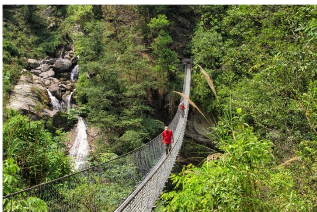
Le pont métallique construit en 2009
