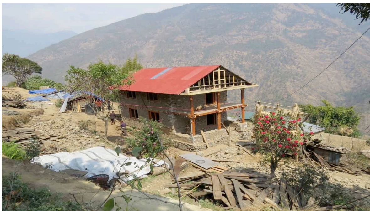
Maison terminée. En arrière l'abri « provisoire » pendant 2 ans.
