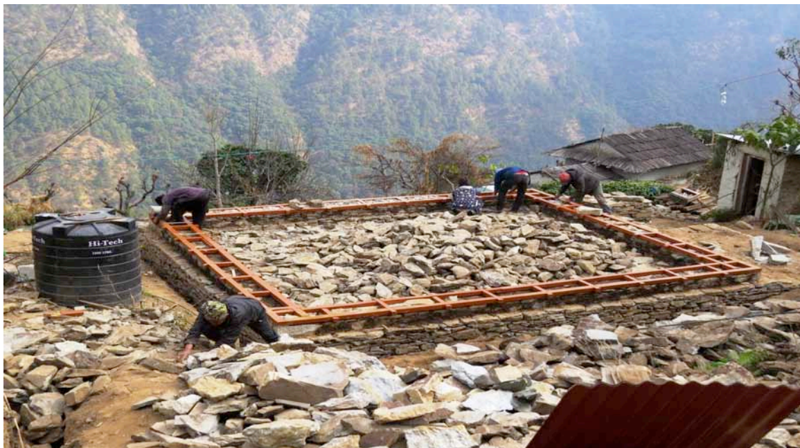
Début de la construction : première bandes parasismiques en bois.
