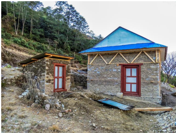
Maison et toilettes de Barkhan
